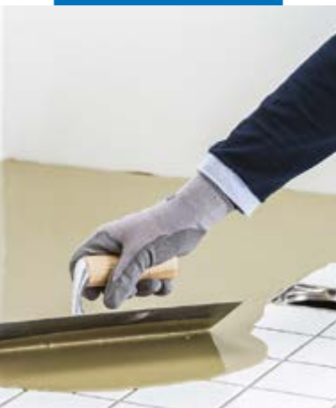
Aanbrengen van Planex HR met een metalen spaan
